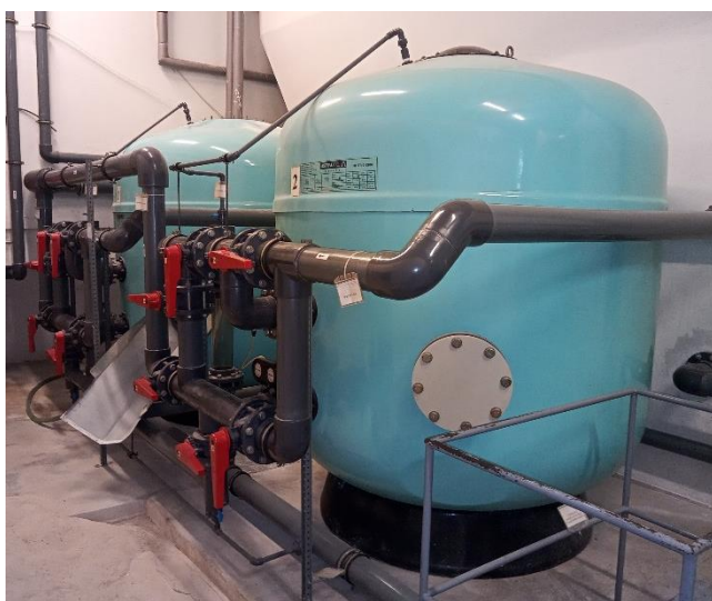
Obrázek 1: Pískové filtry plaveckého bazénu.
