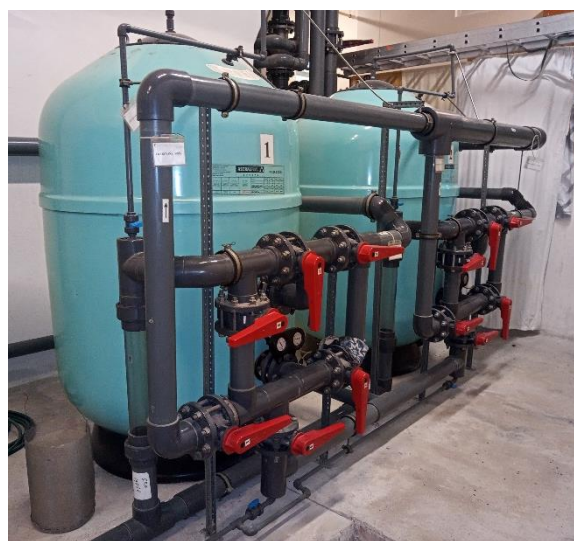
Obrázek 2: Pískové filtry rekreačního bazénu.
